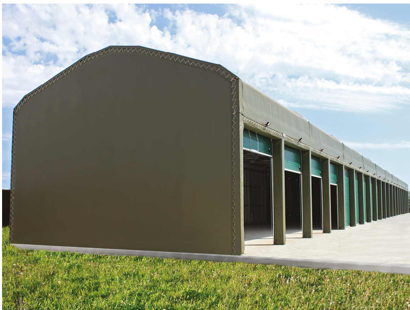
Тенто-мобильная конструкция ВВТ 12 x 100 м. Парковая зона 187-го межвидового учебного центра инженерных войск МО РФ (г. Волжский)
