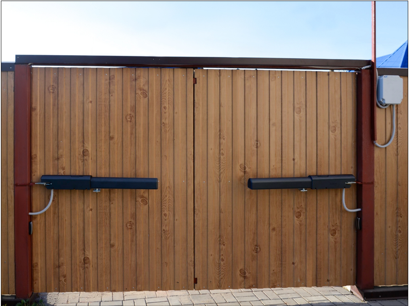
Привод, установленный на ворота из профлиста. Монтаж: компания «100 ворот», г. Воронеж
