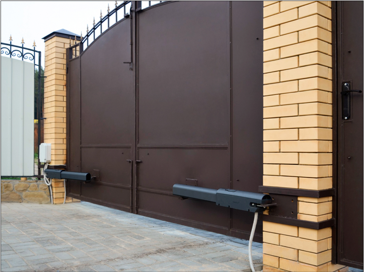
Привод, установленный на металлические распашные ворота. Монтаж: компания «100 ворот», г. Воронеж
