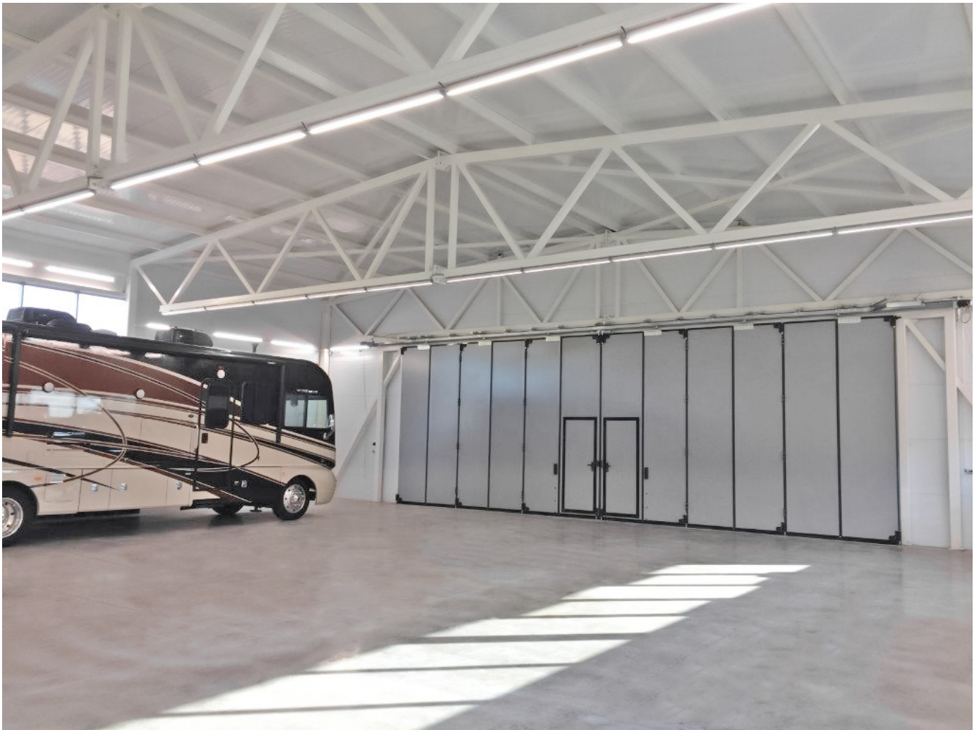
Промышленные складные ворота с нижней направляющей в ангаре для обслуживания автобусов
