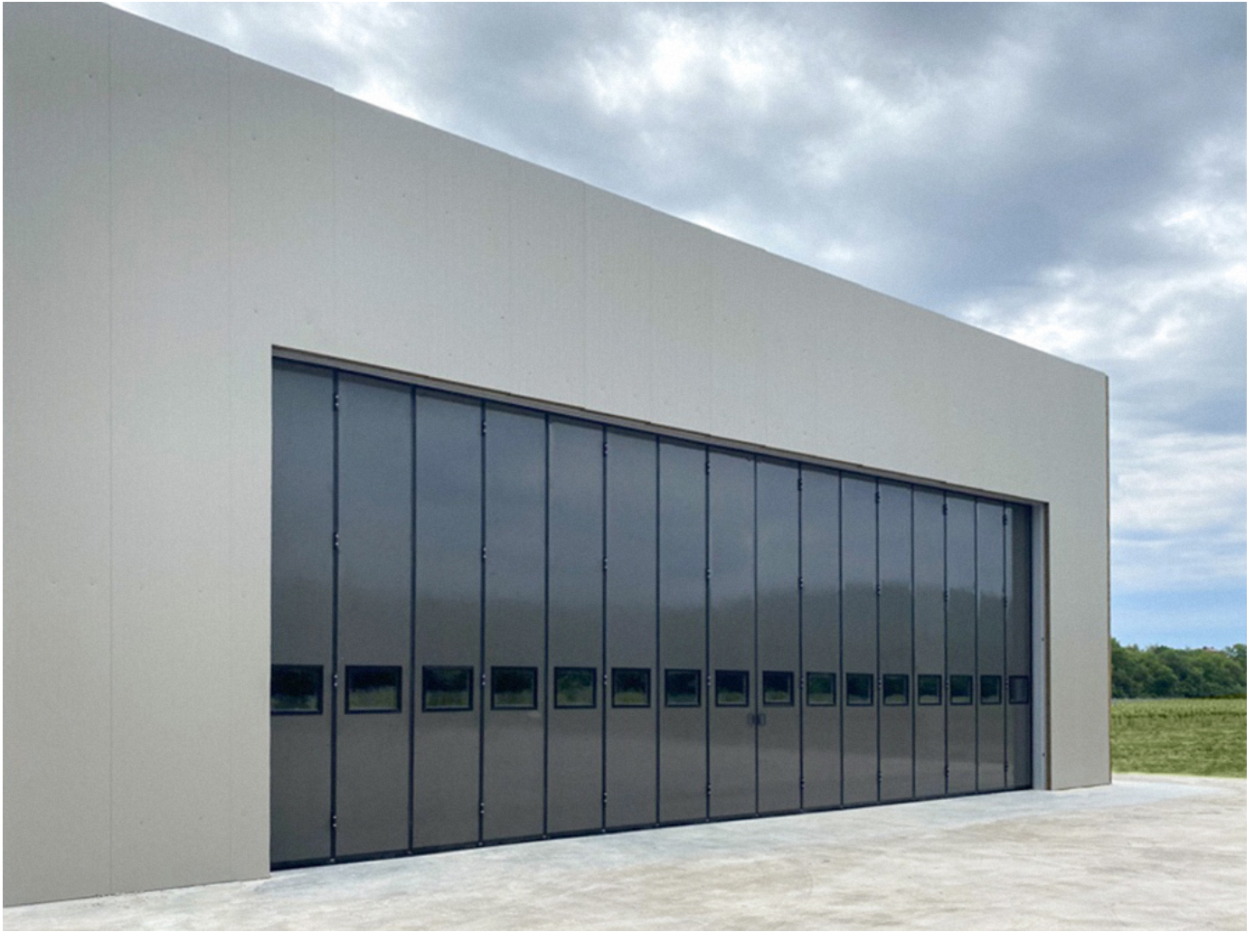
Промышленные складные ворота с нижней направляющей высотой 5 м и шириной 12,8 м (схема открывания 8 + 8). Вид снаружи помещения
