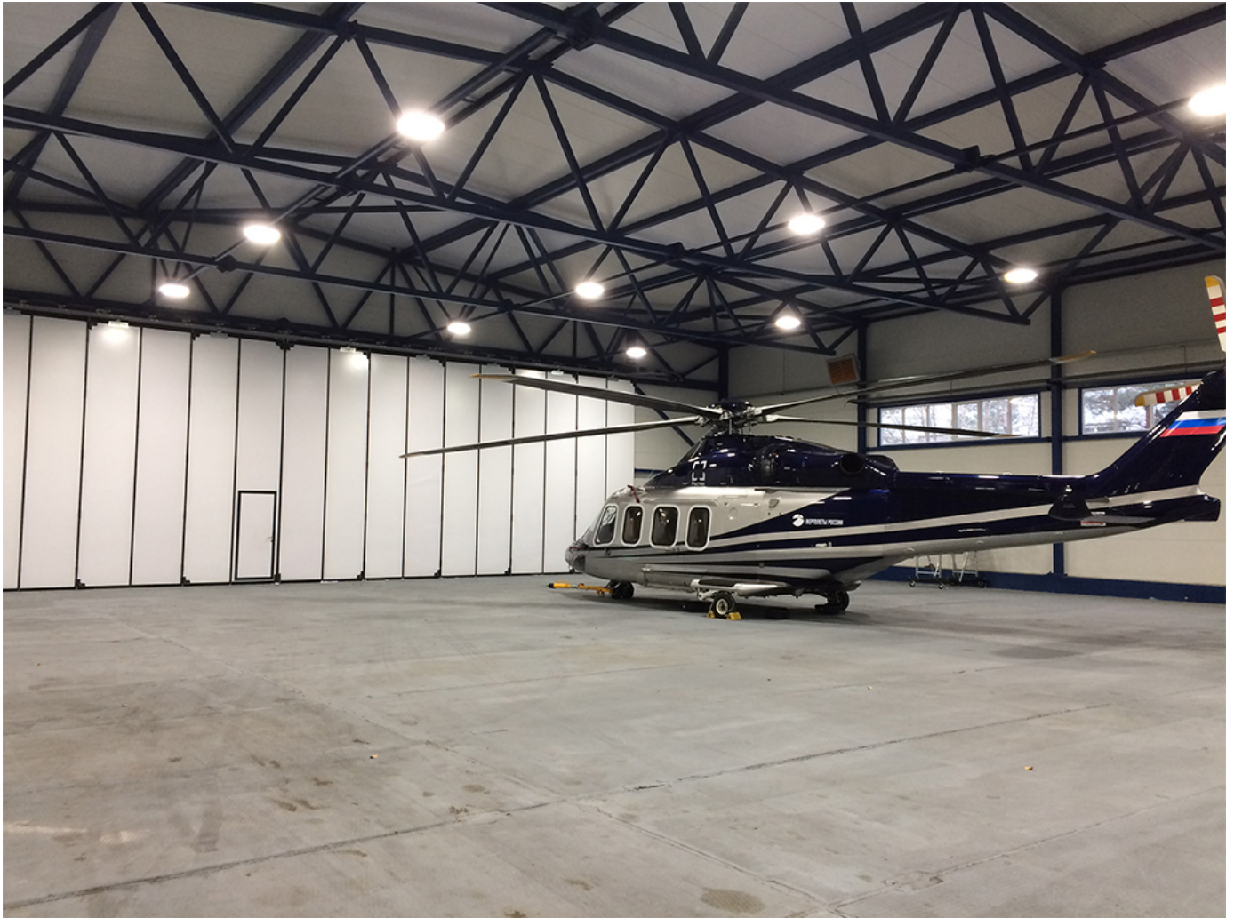
Промышленные складные ворота с нижней направляющей, установленные в вертолетном ангаре
