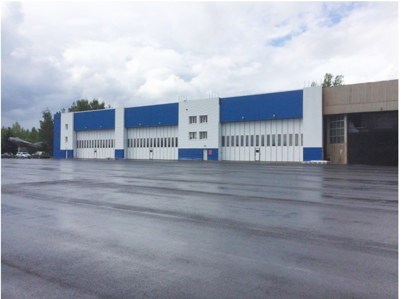
Автоматизированные складные ворота с окнами и калиткой
