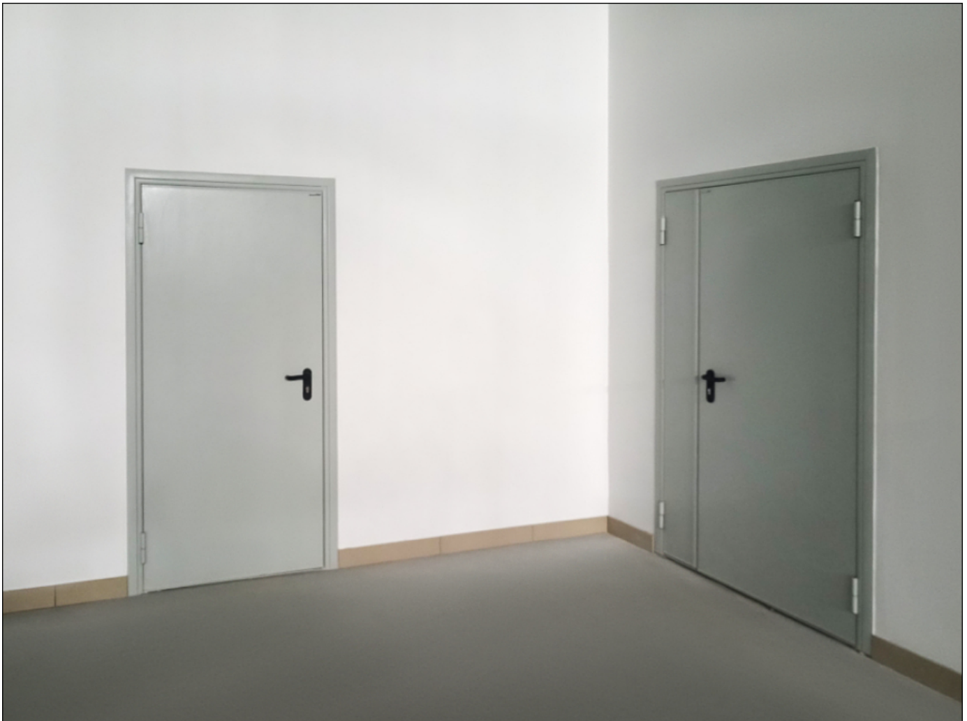
Противопожарные двери одностворчатая и двухстворчатая, установленные в логистическом центре. Нур-Султан
