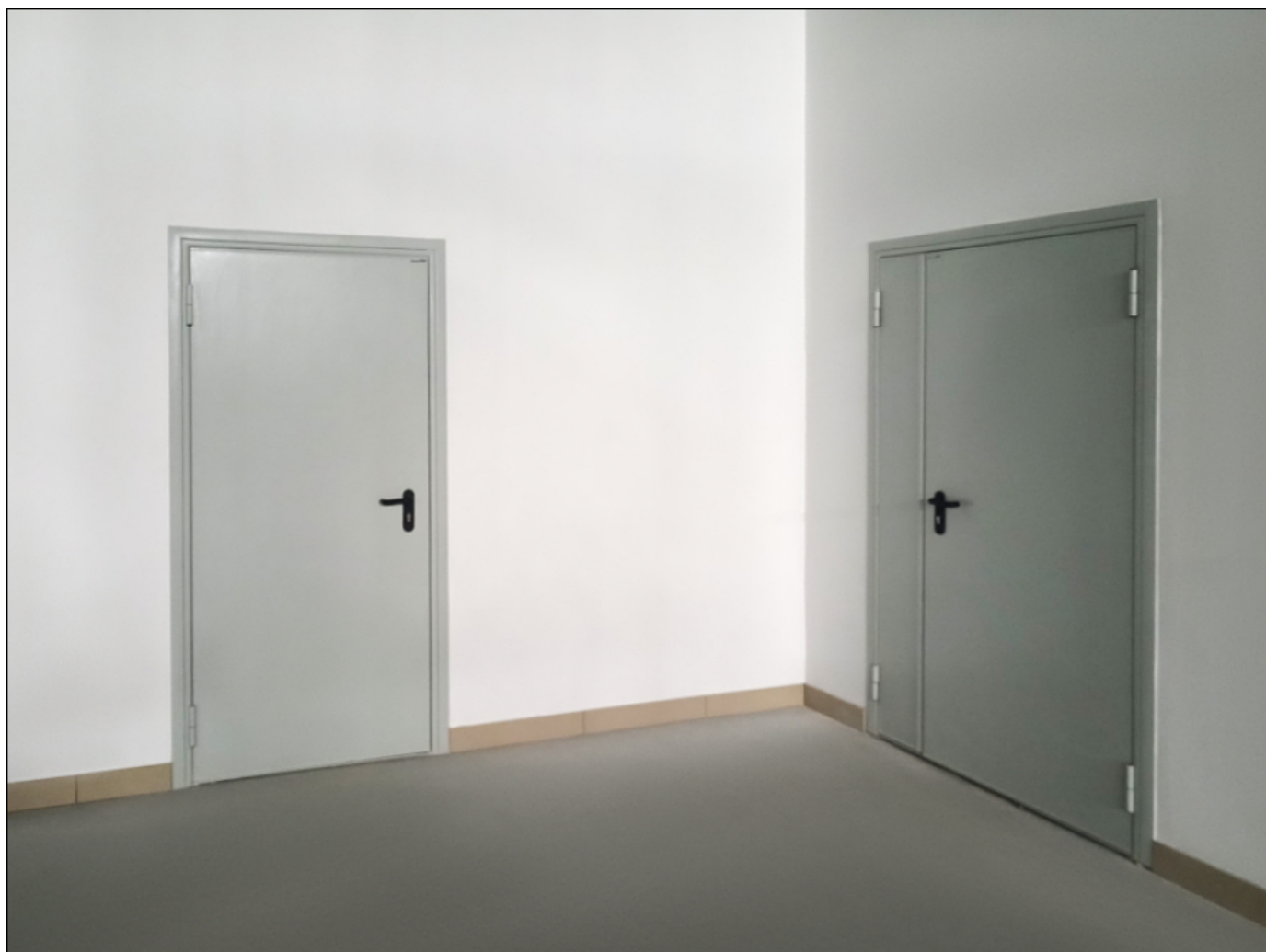
Противопожарные двери одностворчатая и двустворчатая, установленные в логистическом центре, г. Нур-Султан
