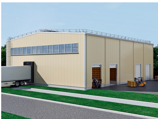
Здания складского назначения
