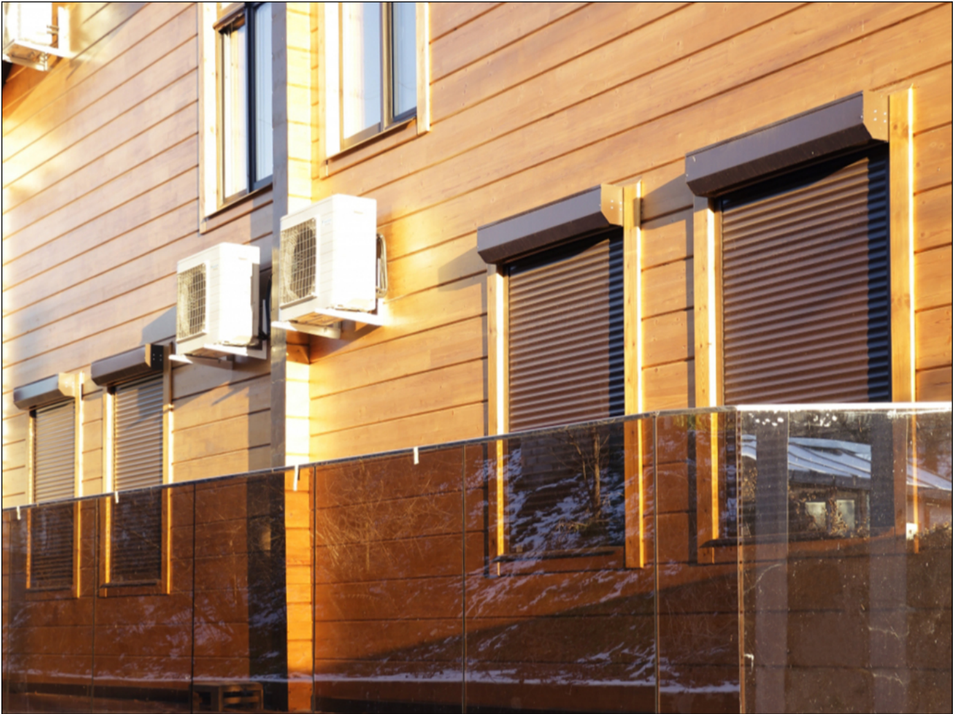
Рольставни оконные в частном секторе. Монтаж: ООО «Старгейт», г. Липецк
