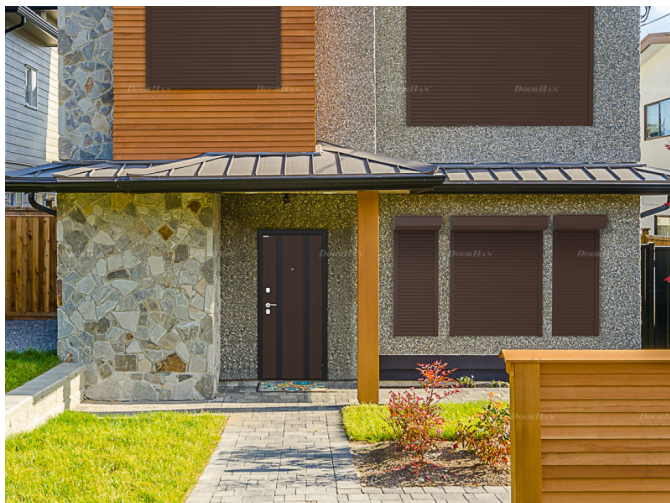
Частный сектор: оконные и дверные проемы
