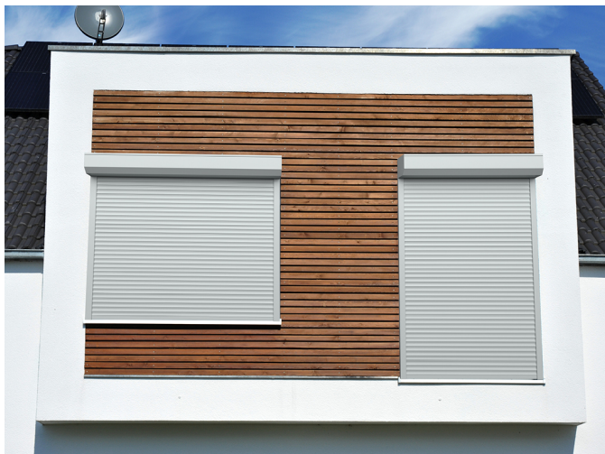
Частный сектор: оконные и дверные проемы
