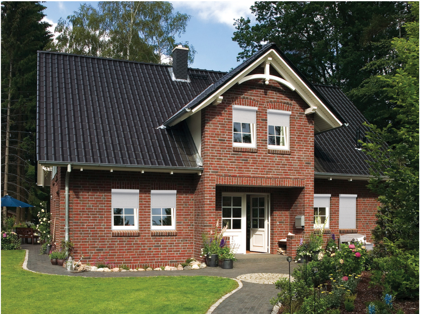
Рольставни оконные в частном секторе
