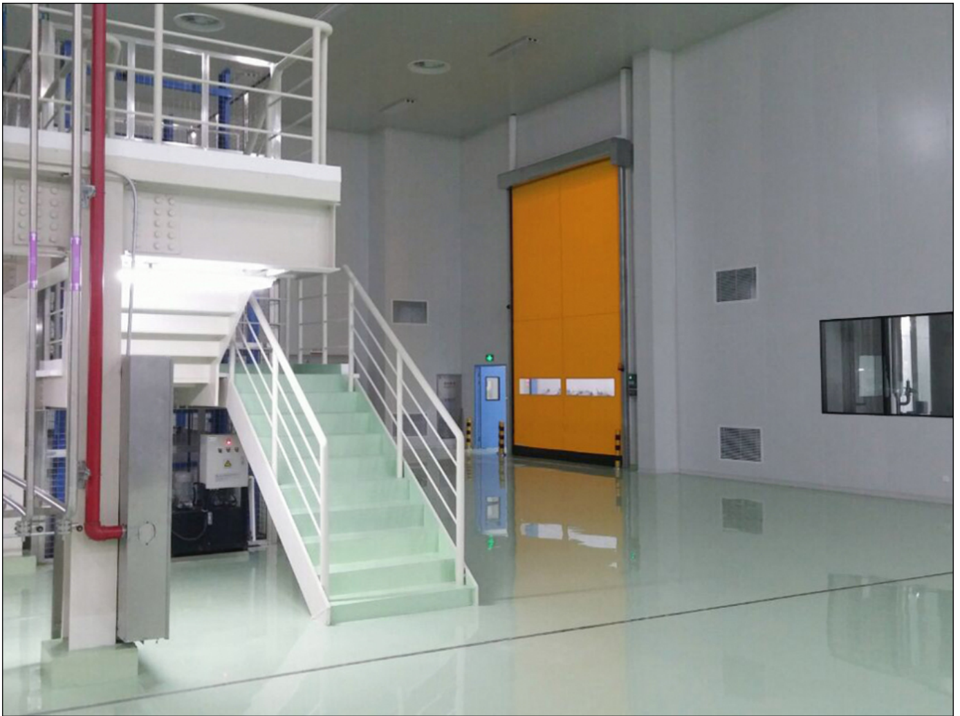
Скоростные рулонные ворота, установленные в производственном помещении
